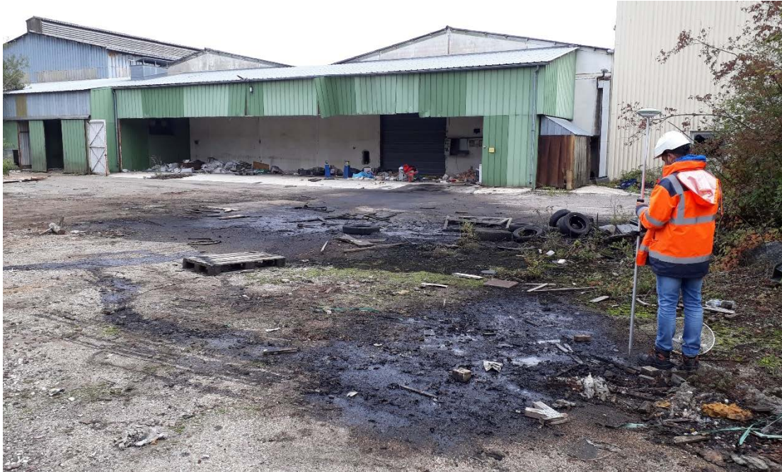
Figure 3 : Situation de la zone impactées au 16/10/2020 après évacuations des déchets dangereux
